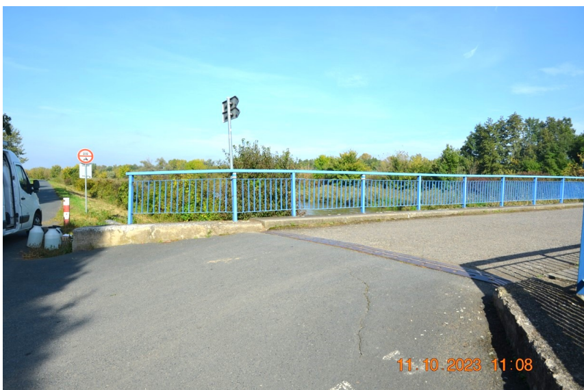
Trhlina ve vozovce při nájezdu z pravého břehu.
