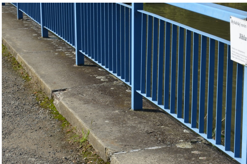
Římsy jsou vyskládány z prefabrikovaných dílců.
