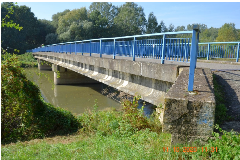
Povodní strana mostu – krajní nosníky jsou potečené vodou ze spár mezi římsovými nosníky.
