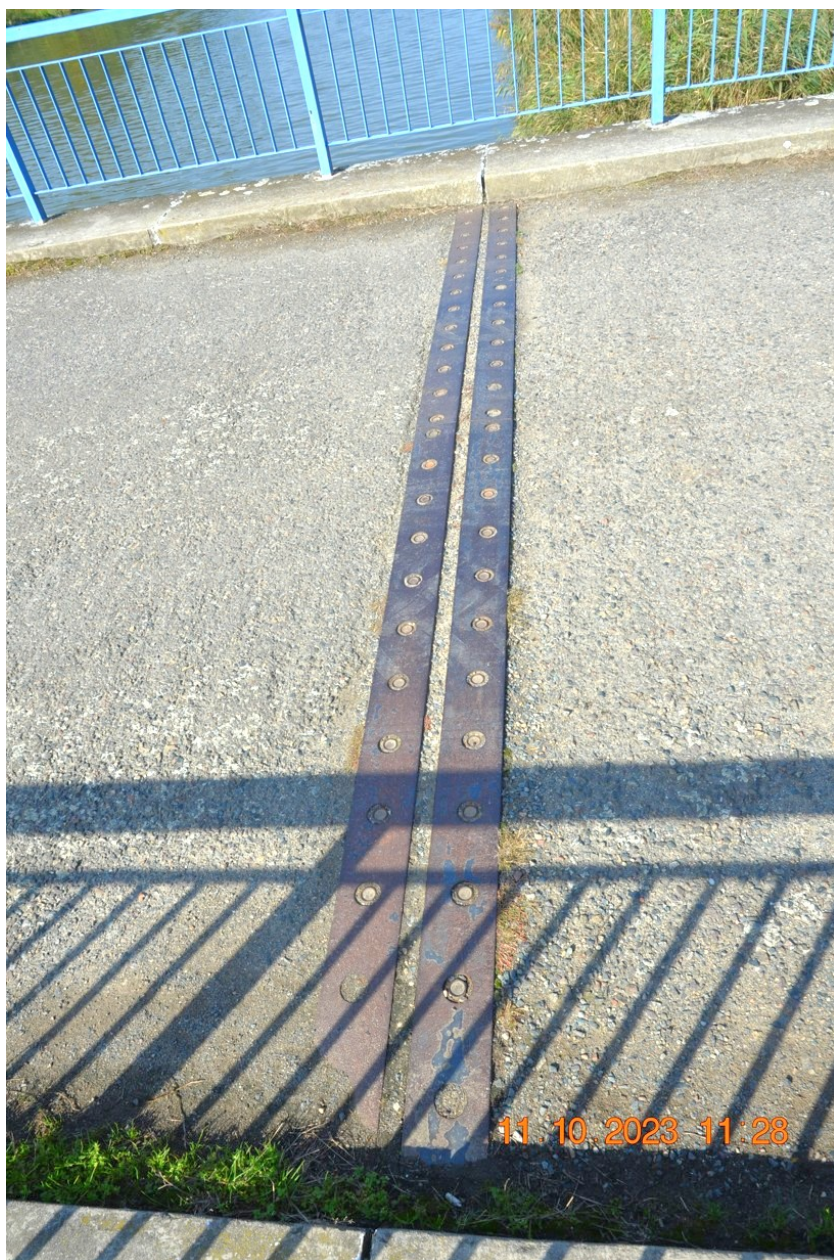
Závěr nad pilířem P3 – u levého břehu.
