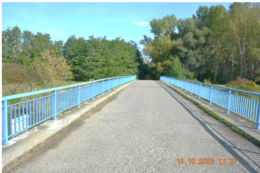
Vozovka na mostě je značně opotřebovaná, je původní a jemné kamenivo je vyježděné. Pohled od pravého břehu.
