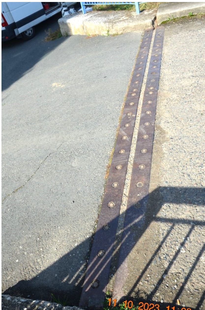
Dilatační závěr nad opěrou 1 – na pravém břehu.
