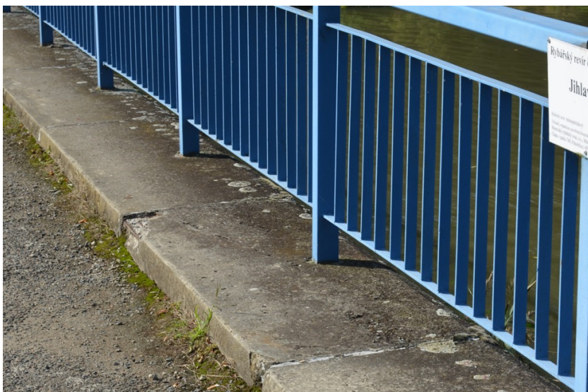
Římky jsou vyskládány z prefabrikovaných dílců.
