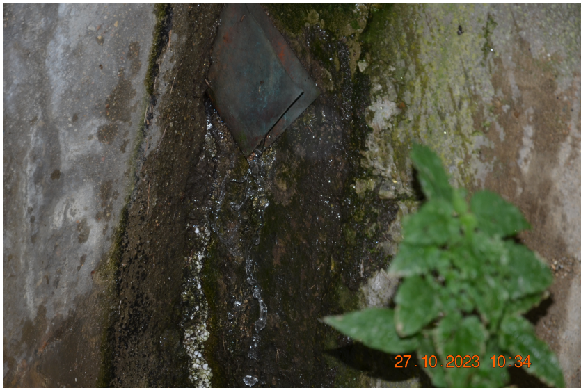
Stékání vody z předchozí fotky po lici opěry 1.
