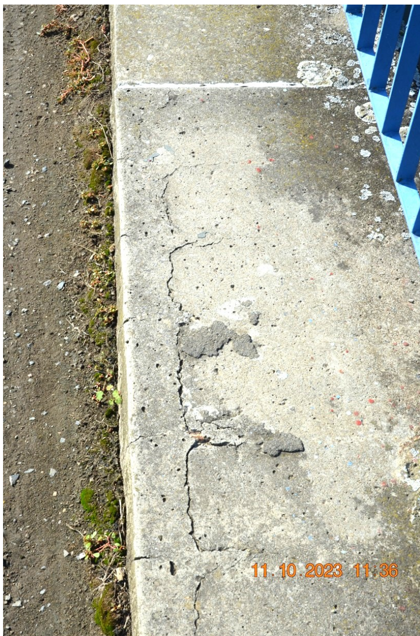
Koroze výztuže římsových dílců – návodní strana.
